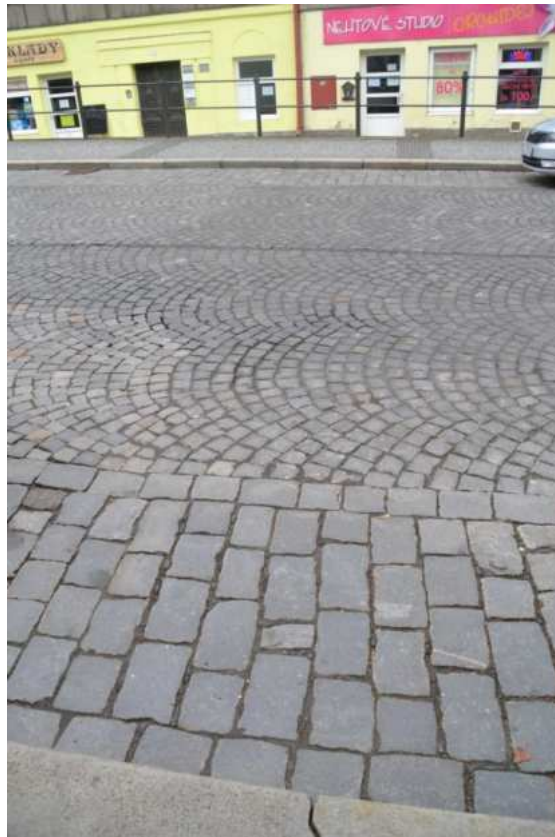
Ulice Palackého, detail mezi křižovatkou s Krajčřřovou ulicřř a Malou Jizerou, foto IP 2016.
