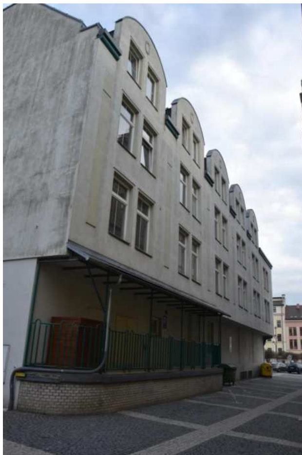
Ulice Mikulášská, foto IP 2013.
