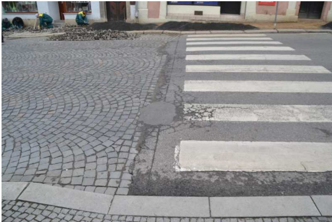
Ulice Palackého, přechod asfaltu a dlažby při východním konci ulice u křižovatky s ulicí Trávnice, foto IP 2016.
