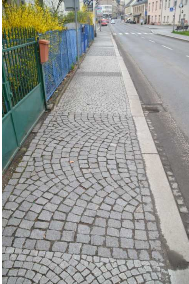
Ulice Sobotecká, detail dlažby chodníku, foto IP 2016.
