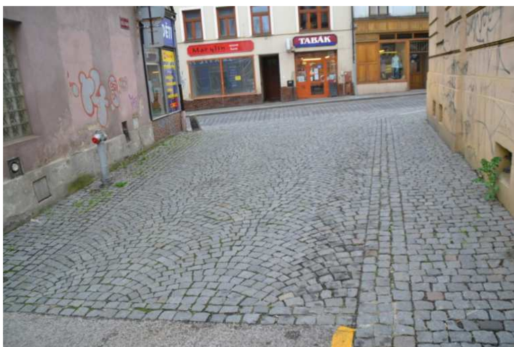
Ulice Abigail Horákové - východní vyústění do Palackého ulice, foto IP 2016.
