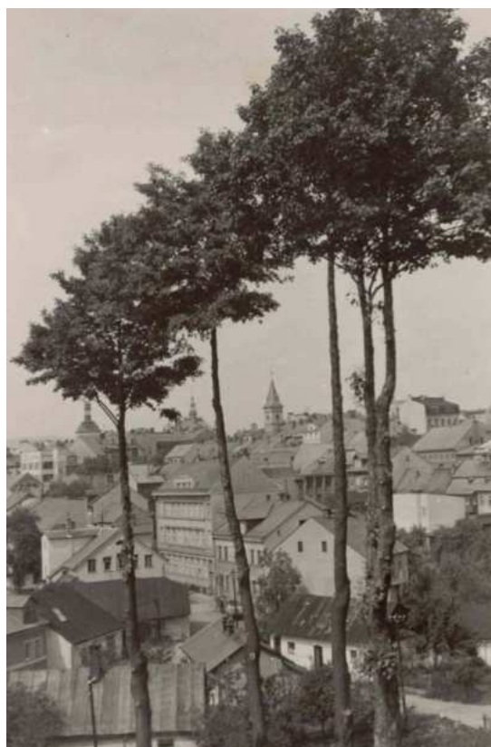
Ulice Tázlerova, (foto sbírka MČR, inv. č. AFT 1065).
