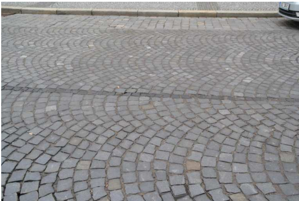
Ulice Palackého, detail mezi křižovatkou s Krajčřřovou ulicřř a Malou Jizerou, foto IP 2016.
