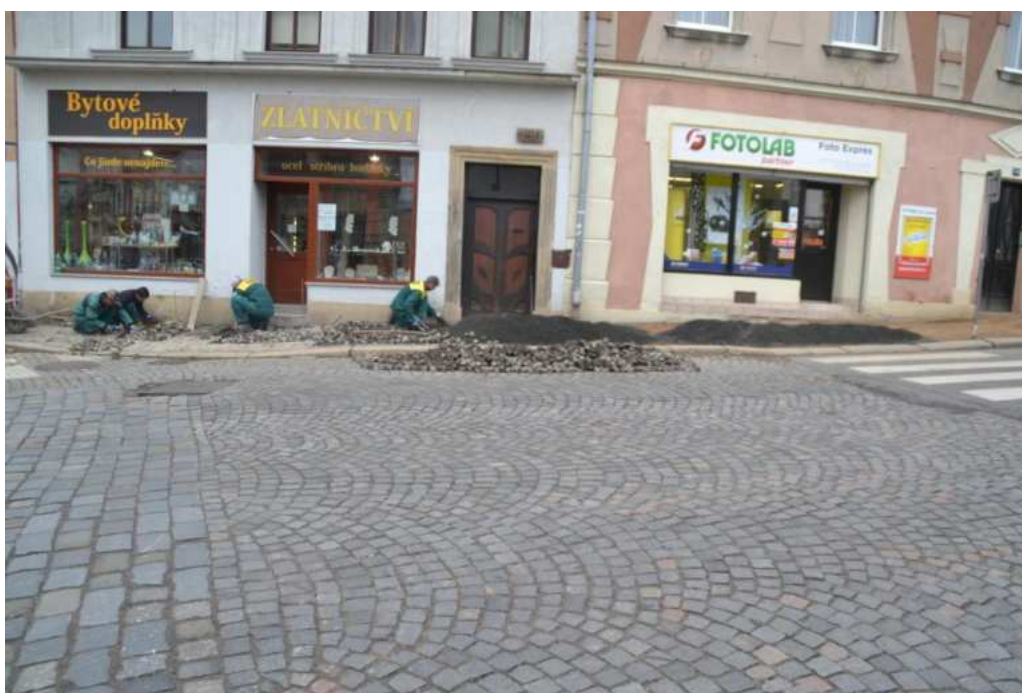
Ulice Palackého, přechod dlažeb u křižovatky s ulicí Trávnice, foto IP 2016.
