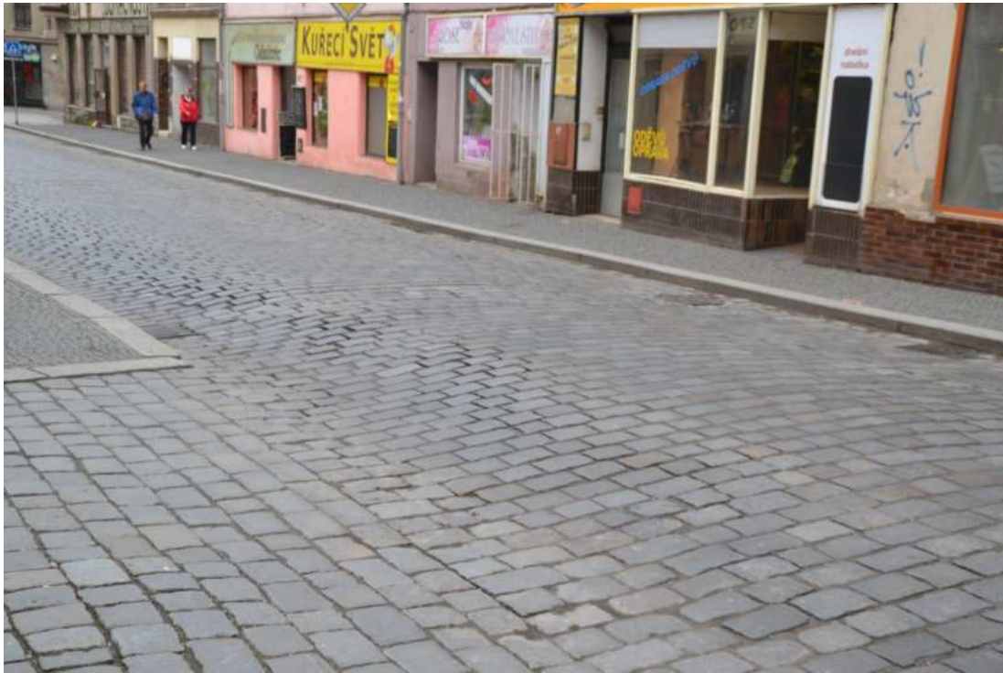
Ulice Palackého, detail dlažby u křižovatky s ulicí Abigail Horákové, foto IP 2016.
