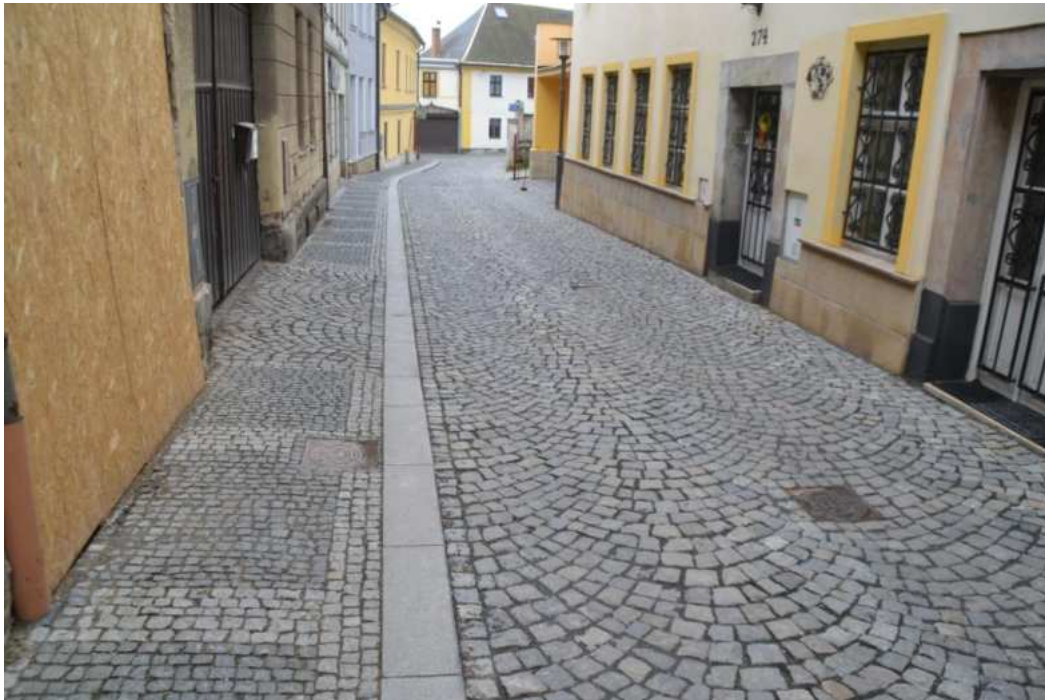
Ulice Vejrichova, celkový pohled od křižovatky s ulicí A. Dvořáka, foto IP 2016.
